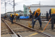
当日のレール交換作業の様子
