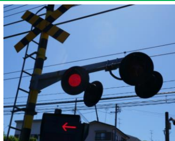
② 踏切せん光灯
