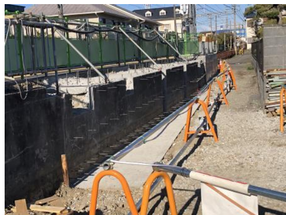
古庄駅のバリアフリー化工事の様子
