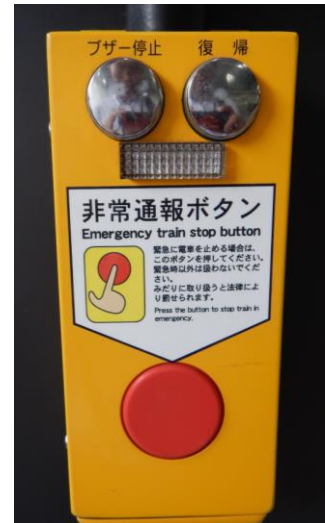
非常通報ボタン
